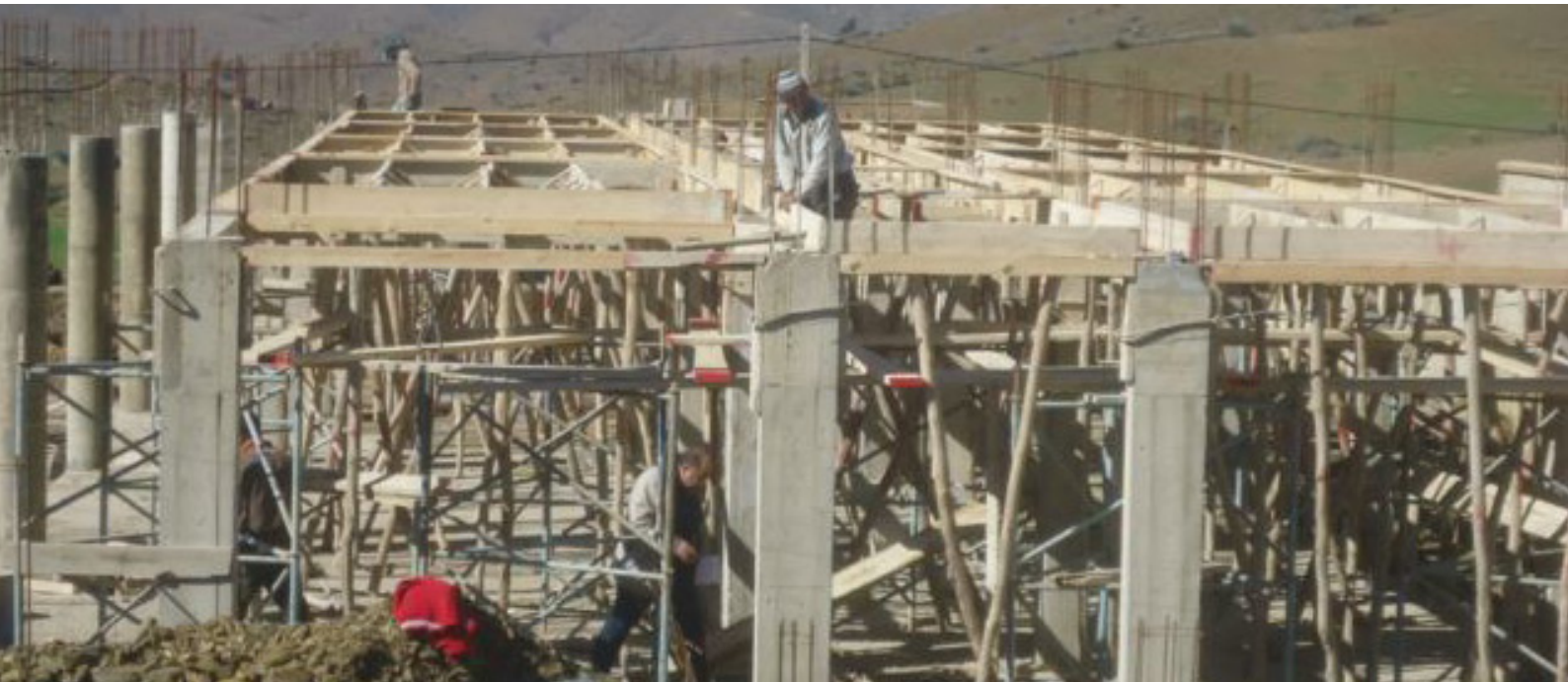
▲ Construction d'une maison d'accueil (internat) au profit des élèves les plus éloignés de l'école centrale de Bouchbal dans la région de Meknès, un projet soutenu par la FICD.
