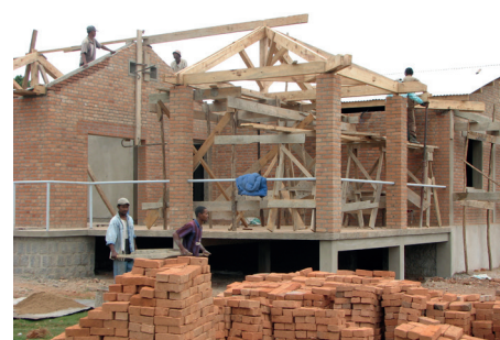
Construction de l'hôtel-restaurant Le Masoandro en 2007
